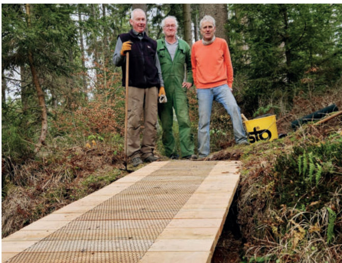
Heinz Krejtschi, Franz Rabenstein und Helmut Griefshammer (von links) haben den Steg auf dem Zuweg zum Kreuzbrunnen erneuert. Foto: Franz Rabenstein
